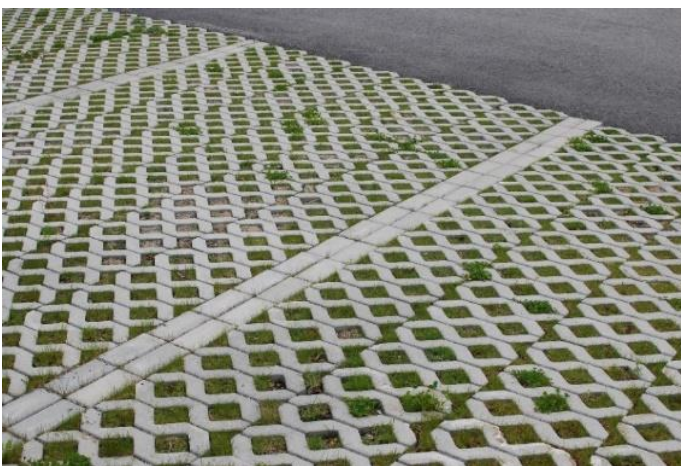
Figur 12. Exempel på genomsläpplig beläggning med hålsten.
