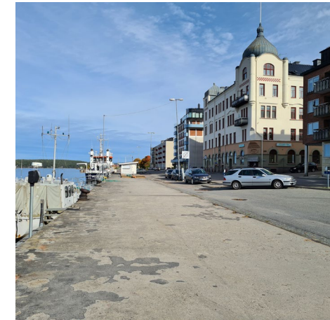
Stora hårdgjorda ytor längs Skeppsbron
