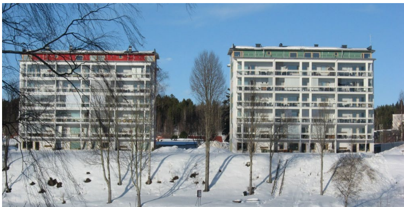
Flerbostadshus i trä (7 våningar) på Älvsbacka strand, Skellefteå.
