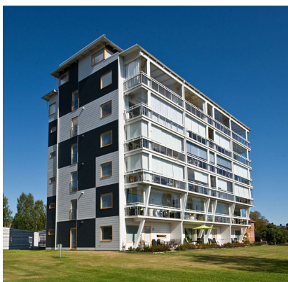
Indragen våning, strukturerande färgpartier och varierad fönstersättning bryter upp skalan på Älvsbacka strand, Skellefteå.
