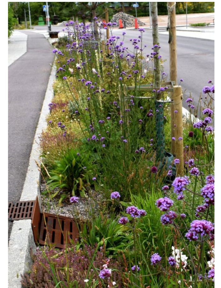
Dagvattenbäddar. Vellinge. Bild: Edge
