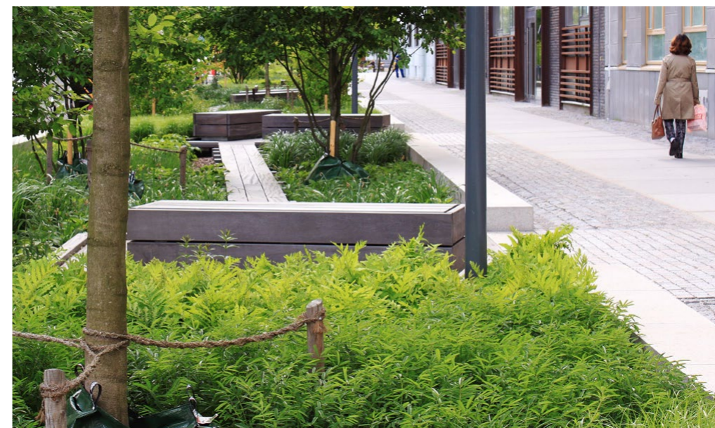
Öppen dagvattenhanteringslösning. Bild: Stockholms stad
